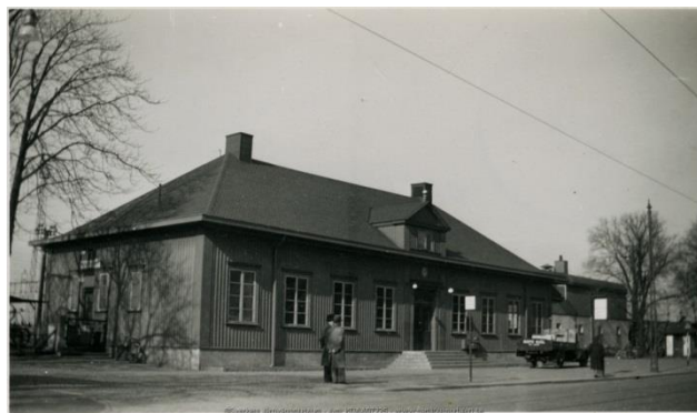
En bild från 1950. Nästan inget har förändrats mer än att Ställverksbyggnaden har tillkommit. Den byggdes 1940.
